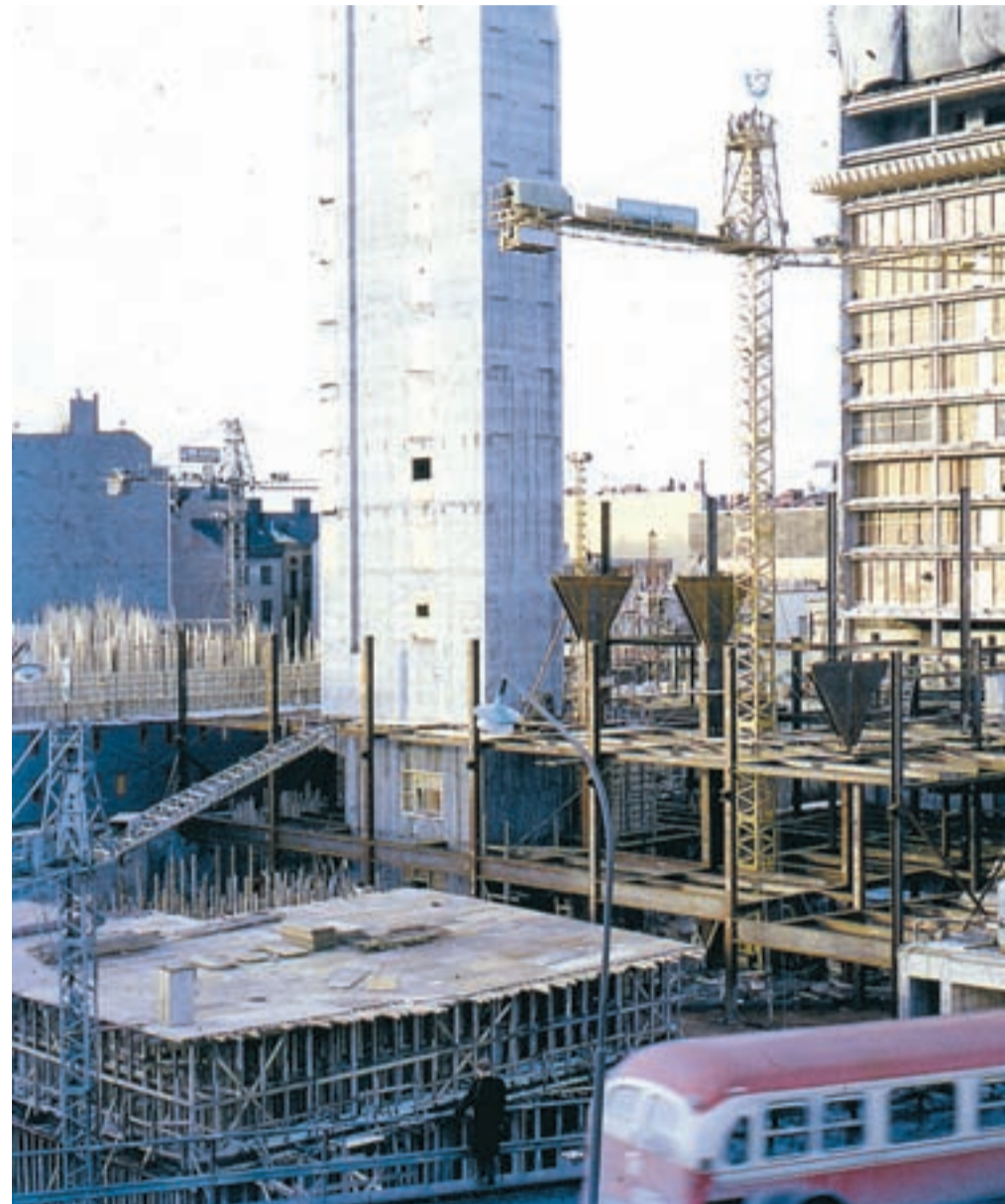
1961 – den femte och sista skrapans första två våningar växer fram. Stommen är av stål.
